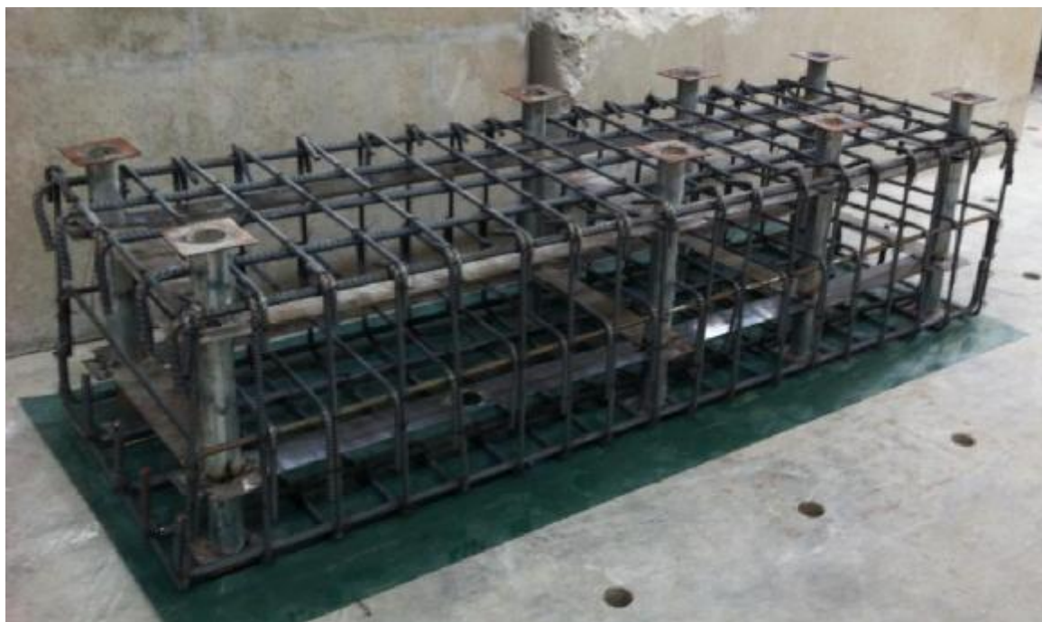
Hình 5-20: Thi công thép để mẫu
