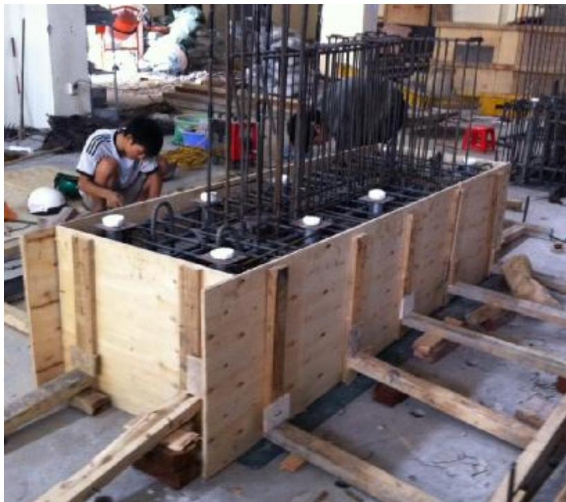
Hình PL3 - 1: Lắp dựng cốt pha đế móng
