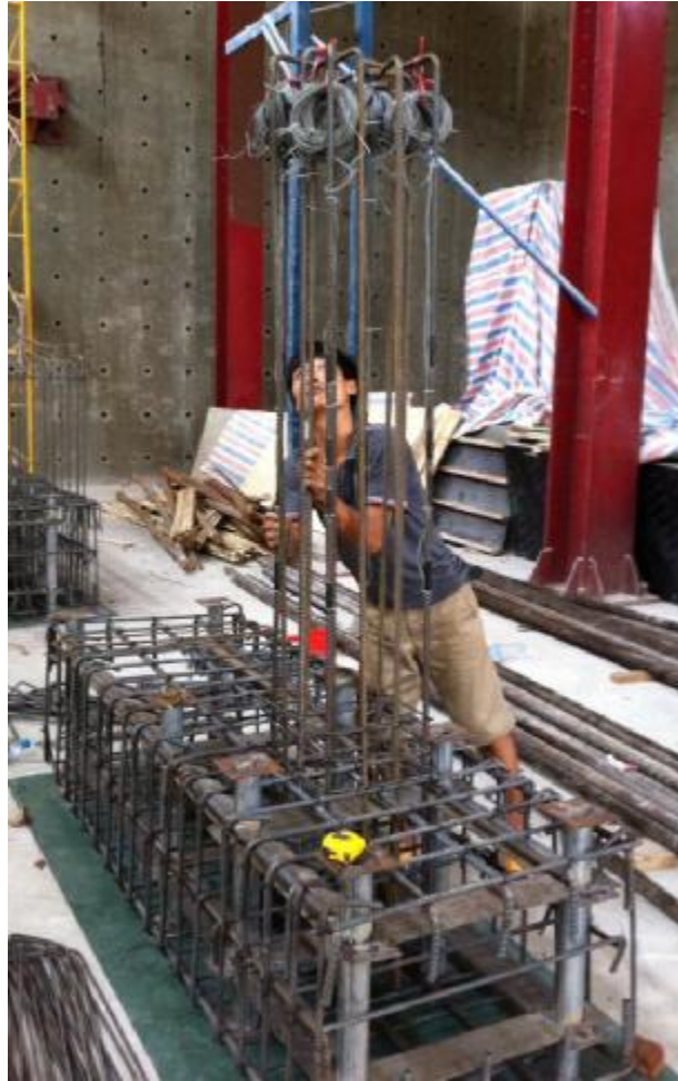
Hình 5-23: Lắp dựng thép cột
