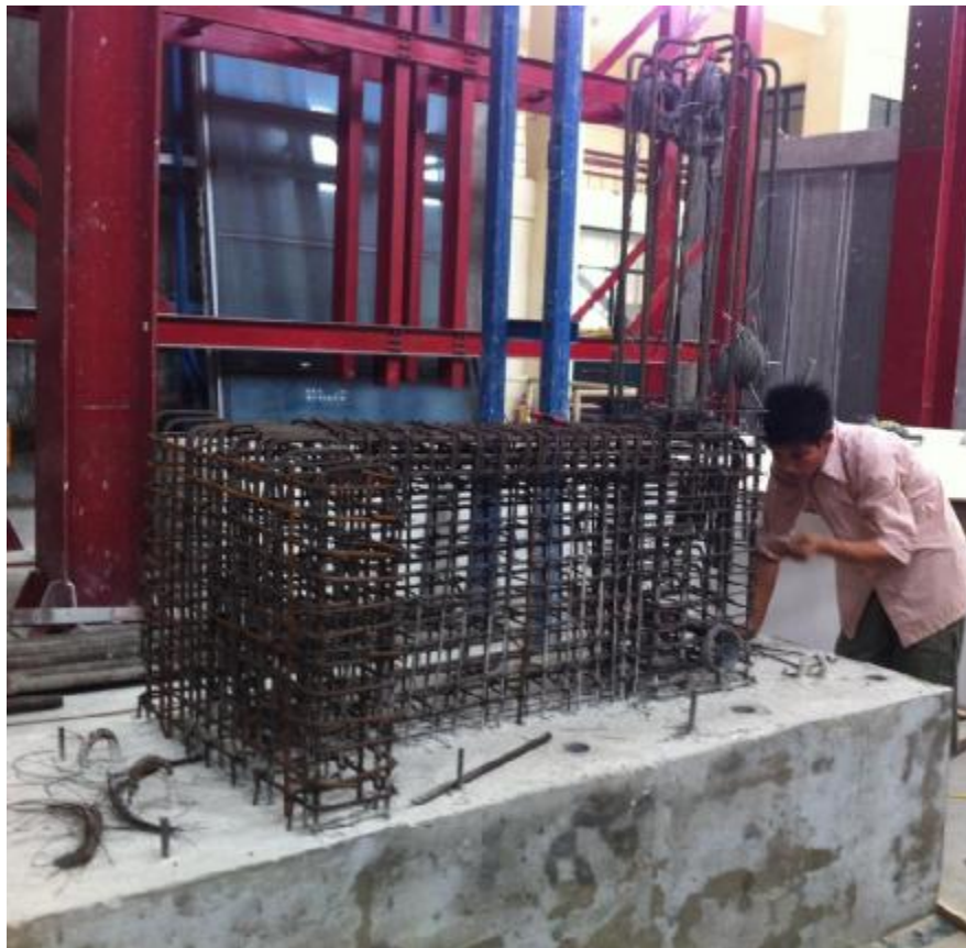
Hình 5-26: Lắp dựng cốt thép dầm cứng
