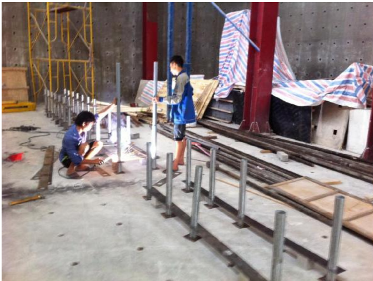
Hình 5-19: Lắp dựng giá định vị bu lông móng
