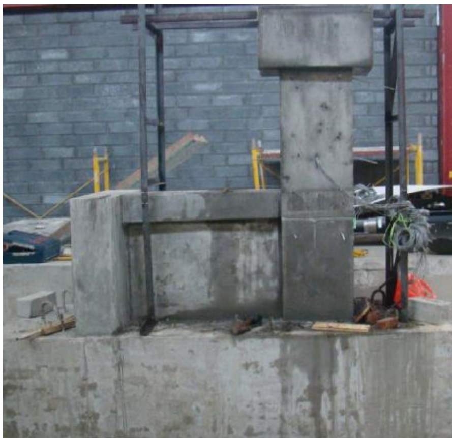
Hình 5-29: Hoàn thành việc đổ bê tông mẫu
