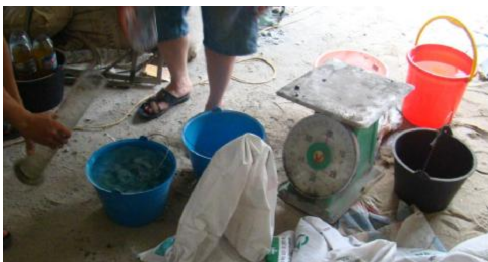
Hình 5-25: Cân đong vật liệu để trộn bê tông theo cấp phối thiết kế
