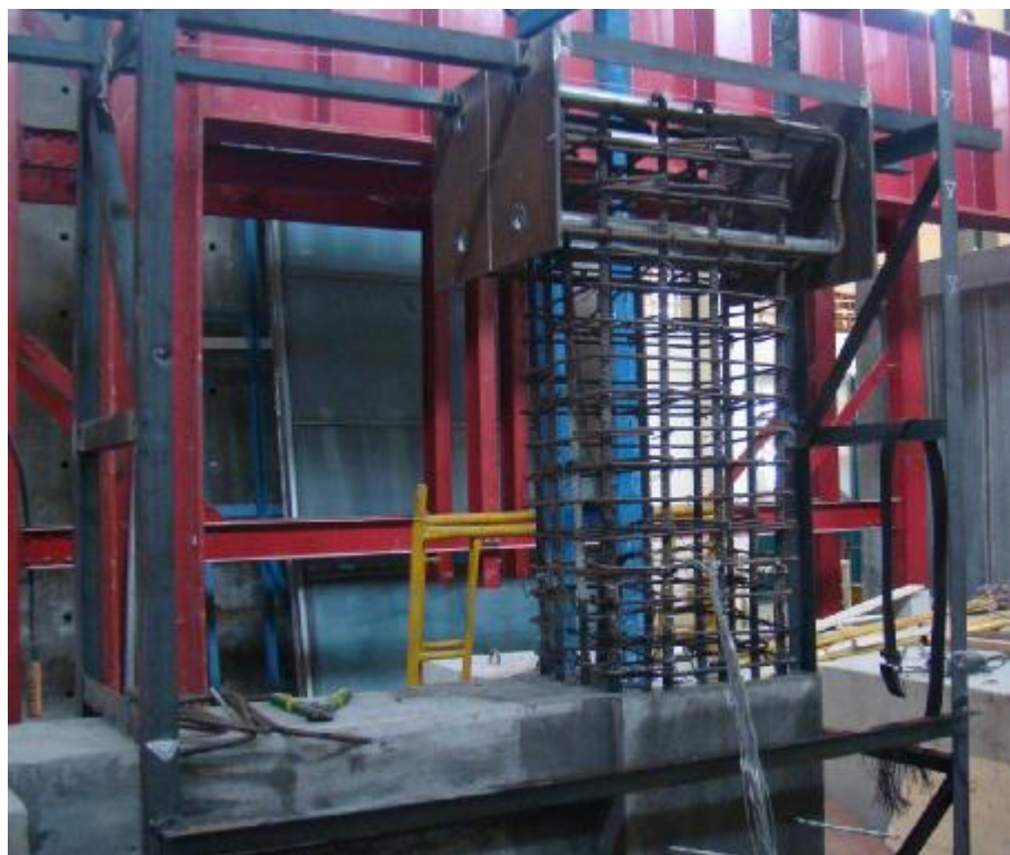
Hình 5-28: Biện pháp thi công để lắp chi tiết đặt sẵn để bắt đầu kích
