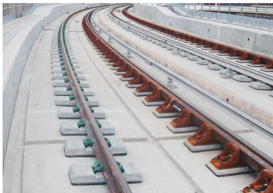
Hình 1. Đường ray không ballast
