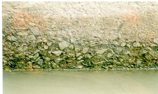
Hình 3. Dạng BT bị ăn mòn ở vùng “chua”
